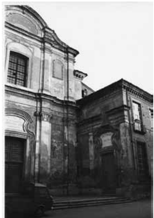
41. Castelnuovo Scrvia, S. Ignazio, Kirchenfassade mit Kollegsgebäude.
